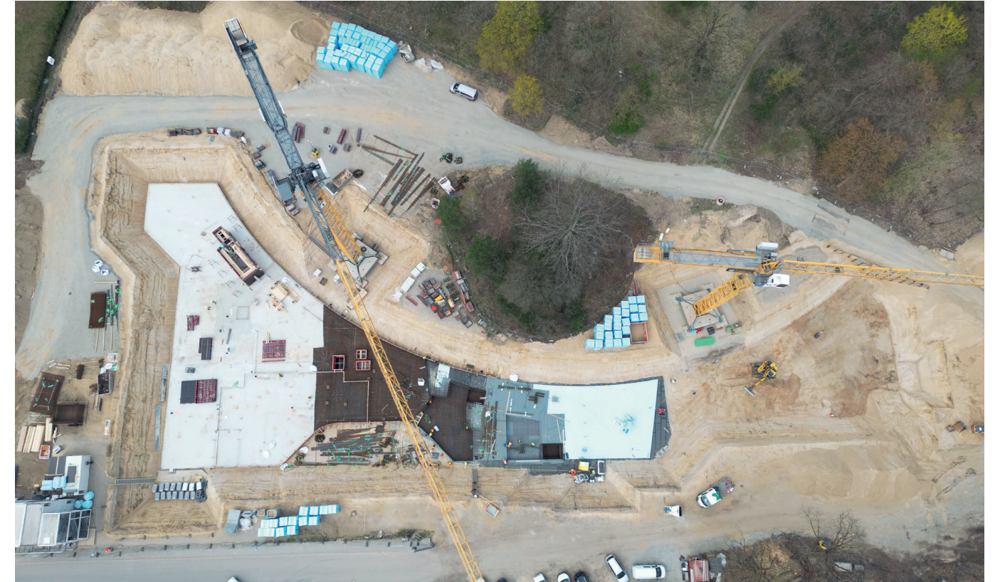
Bild: Unscheinbar, aber zentral: Die Bodenplatte legt die Grundlage für Kontur, Leitungen und Aufzüge © Landkreis Potsdam-Mittelmark
