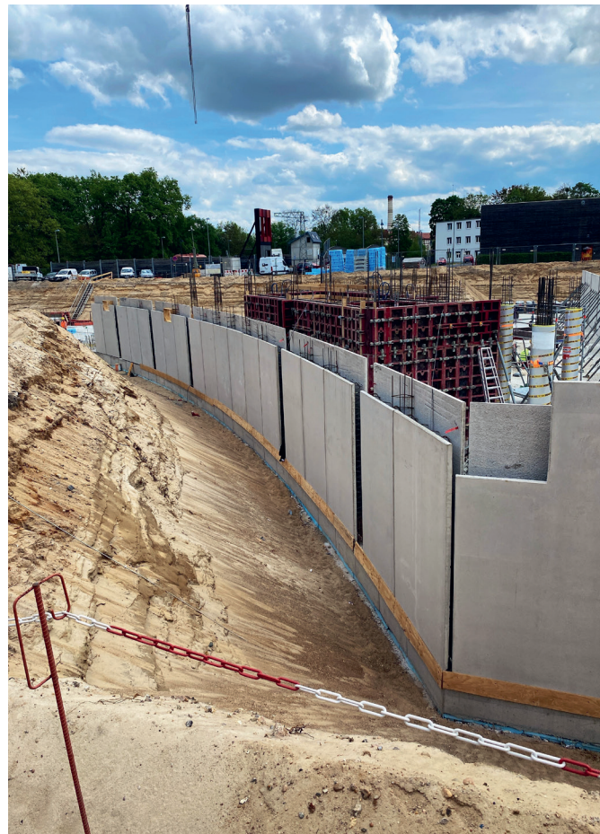
Bild: Vom Fundament in die Höhe: Die ersten Wände stehen © Landkreis Potsdam-Mittelmark
