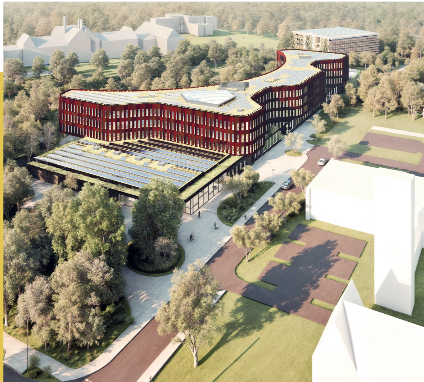
Bild: Blick auf den künftigen Verwaltungsstandort in Beelitz-Heilstätten © BOLLES+WILSON
